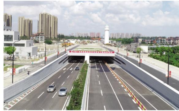
7月30日拍摄的杭州钱塘过江隧道入口(无人机照片)。当日,由中铁十四局承建的杭州钱塘过江隧道建成通车,杭州再添一条过江通道。钱塘过江隧道全长4616米,隧道为双向双向六车道,是目前钱塘江底最大直径市政工程盾构隧道,也是杭州钱塘快速路的重要组成部分。
