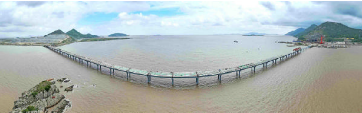
后门山至梁横山桥梁本月底架通 普陀区展茅街道螺门后门山至梁横山桥梁工程，已完成总工程量的85%，计划于本月底实现贯通。该工程总投资约1.58亿元，桥梁全长1090米。 摄影 记者 陈永建
