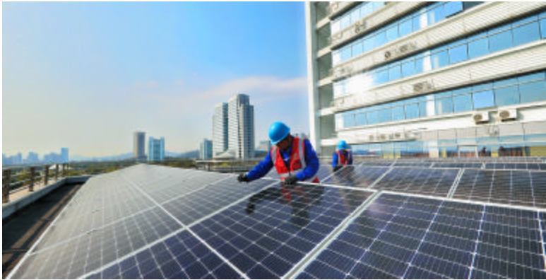
2022年3月29日，启明安装公司光伏班组人员正在舟山市政府机关事务1号楼安装光伏板
