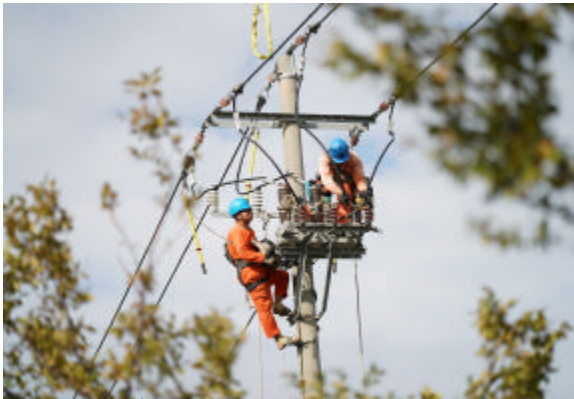
今年“梅花”台风期间抢修配电设施 本版图片由浙江启明电力集团有限公司提供
