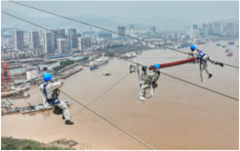
2022年3月9日，启明安装公司“蜘蛛侠”们进行春检作业
