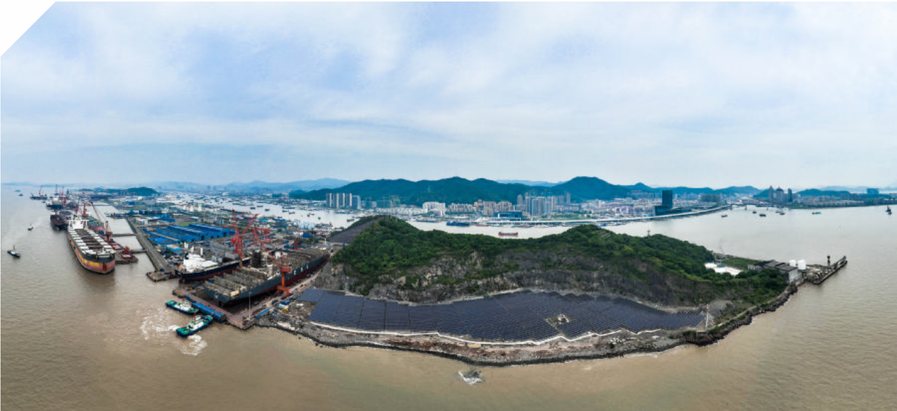
2022年1月，由国网舟山供电公司自主研发建造的浙江省首个“不拆瓦”光伏建筑一体化屋顶光伏项目正式投运
