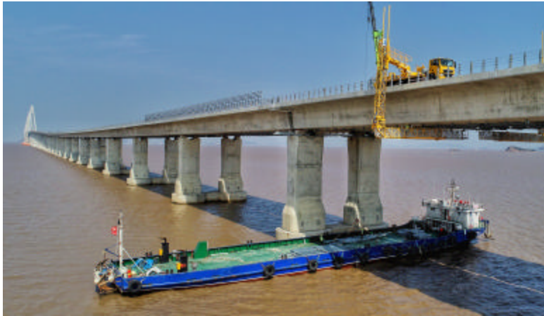
2021年7月26日，全省跨海距离最长的舟岱大桥随桥电缆工程正在加班加点建设中
