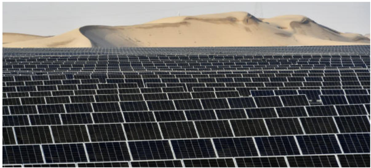
这是2月18日在武威市凉州区九墩滩光伏治沙示范区拍摄的一处光伏发电项目(无人机照片)。近年来，甘肃省武威市凉州区抢抓以沙漠、戈壁、荒漠地区为重点的大型风电光伏基地建设机遇，探索光伏治沙新模式，利用腾格里沙漠未利用国有土地50万亩，规划建设九墩滩光伏治沙示范区，总装机容量1500万千瓦。园区建成后，预计年发电量260.25亿千瓦时，年减少二氧化碳排放2939.1万吨，年节约801.57万吨标煤，治理沙漠43万亩，实现经济效益、生态效益和社会效益共赢。新华社记者 范培坤 摄
