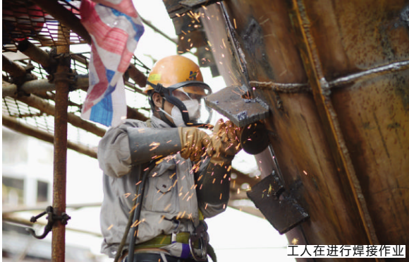
工人正在进行焊接作业
