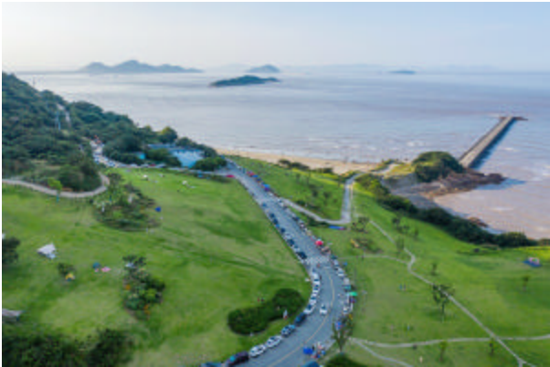
空中俯瞰临海而建的舟山普陀区螺塘线生态公路(8月6日摄,无人机照片)。螺塘线以“生态交通”为原则打造,将沿途的渔家村落、茶田、海滩、山坡、民宿等山海风光串连起来,移步换景,路景相依。
