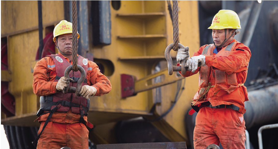
甬舟铁路西堠门公铁两用大桥建设现场,建设者们开足马力,抓紧施工 摄影 记者 姚凯乐
