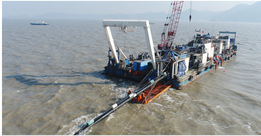
嵊泗县大陆（小洋山）引水工程海底输水管道敷设现场 摄影 记者 刘凯
