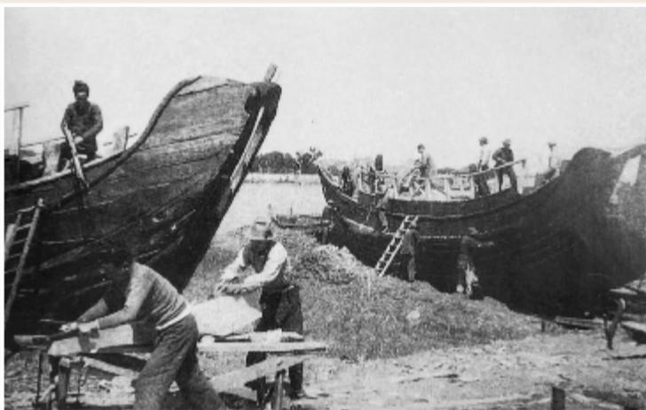
部队修船队(组)在海滩抢修破损船只
