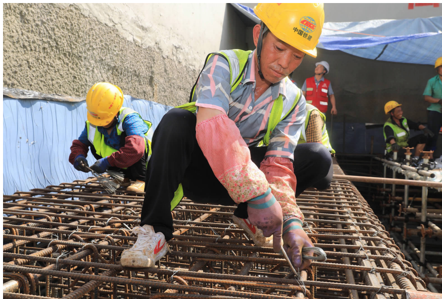
甬舟铁路金塘海底隧道工程工地,工人在绑扎钢筋 记者 陈永建 摄
