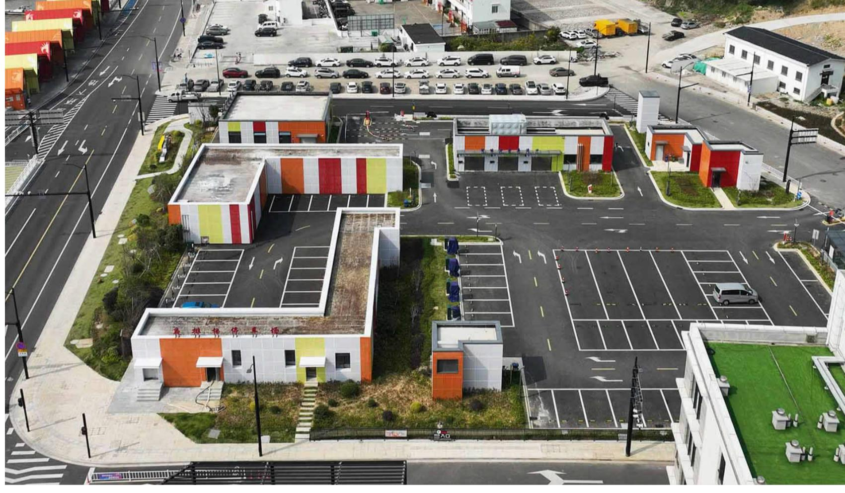
近日,在沈家门宝龙天地西侧,当地首个智能停车库正式投入运营。据了解,该停车库总车位297个,其中,地面停车场车位61个,地下有两个停车库,A库为地下三层全自动驾驶车库(室内无车道且无人员停留的机械式汽车库),车位162个;B库为地下一层自走式地下停车库,车位74个。 记者 陈永建 通讯员 刘华杰 摄
