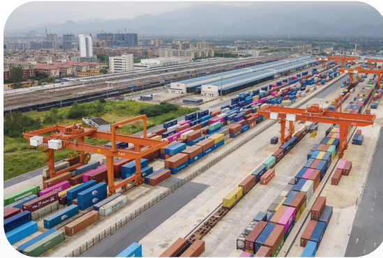
金华市金东区华东国际联运港
