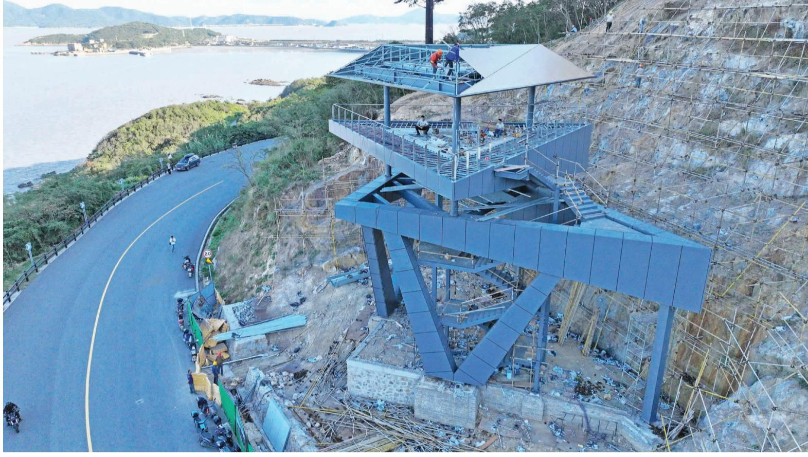
昨天，在普陀区螺塘线附近，一座造型新颖的景观平台正在建设中。据了解，该工程为螺塘线道路附属工程林地管护平台一期项目工程，建造的平台高16.6米，宽17.5米，预计在12月中旬完工，届时螺塘线又多了一处新景观。
