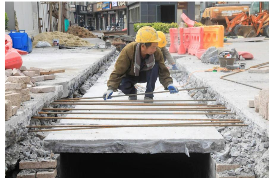
近日,工人们正在对嵊泗县枸杞乡排洪减涝建设工程进行排涝渠封闭施工。工程将通过中心区改扩建雨水管网、增设雨水强排设备、部分特殊路段实施雨水截流以及改造排海口等措施,全面提高主要街道排洪抗灾能力。工程预计年底完工。
