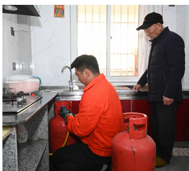
工作人员为岛上居民上门安装并检修
