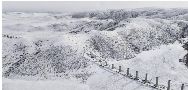
当日，由中铁二十五局承建的西宁至成都铁路四川段首座隧道——班佑1号隧道顺利贯通，全线隧道施工进入攻坚阶段。班佑1号隧道位于四川省阿坝藏族羌族自治州若尔盖县境内，平均海拔3500米，为单洞双线隧道，设计时速250公里，隧道全长582.23米。
